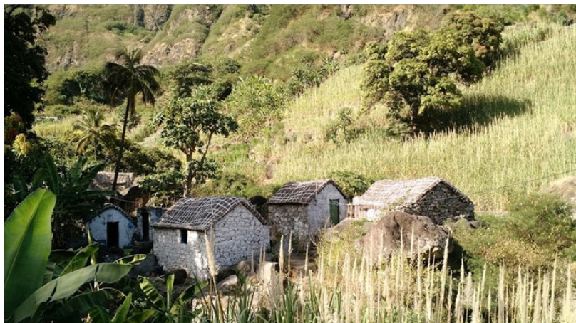
Figura 9. Exemplo de arquitetura vernacular na ilha de Santo Antão (Fonte: Acervo da pesquisadora).
